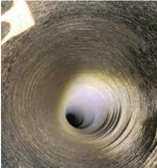
Un conduit de cheminée après débistrage.
